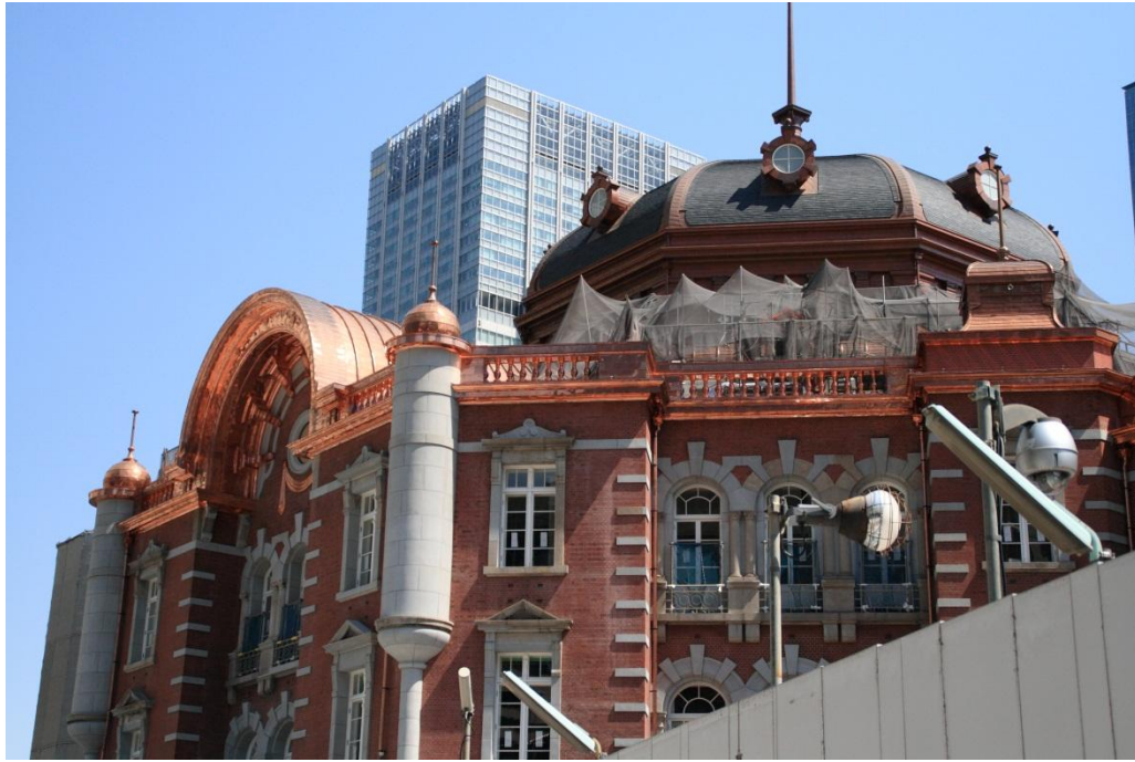
復元工事の進む東京駅舎と TOKYO STATION CITY のビル(現在外見工事は終了)
