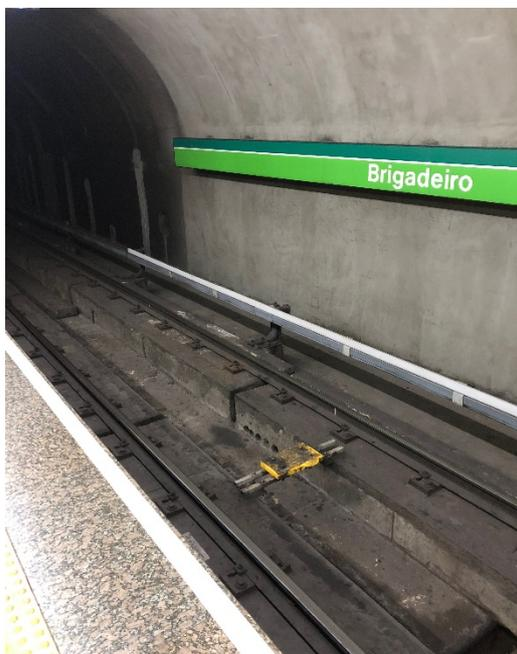
線路幅は1, 2, 3号線では1600mm、4, 5号線では1435mm (日本の新幹線や京浜急行、京成電鉄などと同じ) です。
