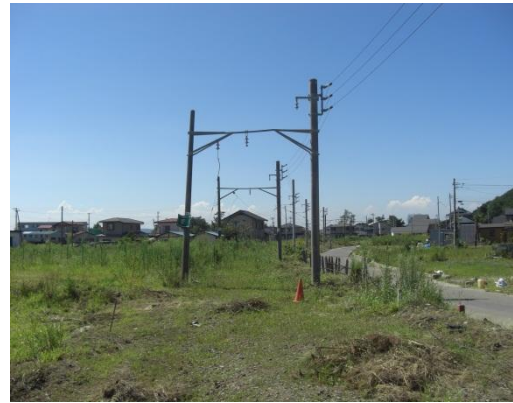
(線路は撤去されている)
