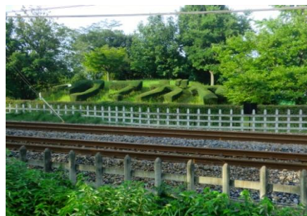
高崎線との立体交差跡で築堤は当時の半分程度の高さ
