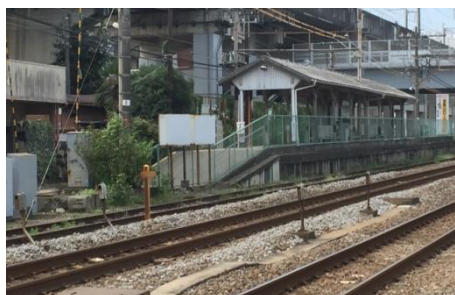
上熊谷駅の手前側は、妻沼線のホームでフェンスがある
