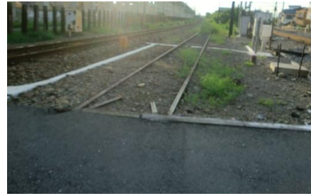
手前の線路が妻沼線 踏切では線路の上からアス ファルトがひかれている
